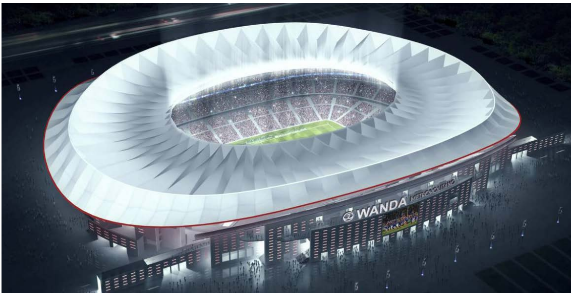
◀ Estadio Wanda Atlético de Madrid España. Área cubierta 46,500 m 2
